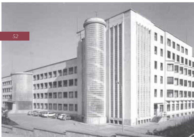
Nuevo Hospital Provincial. Archivo fotográfico Manuel Solórzano.
